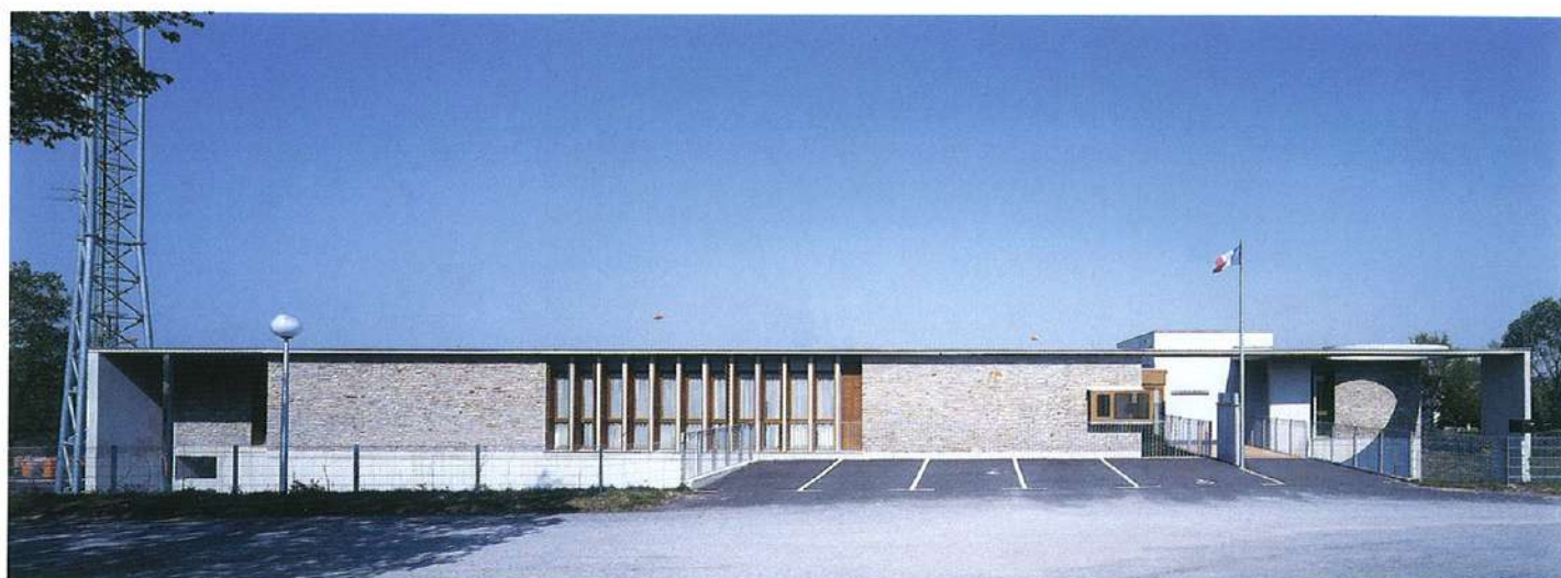
Vue de la façade ouest
