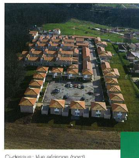
Ci-dessus : Vue aérienne (nord) Ci-contre : Vue aérienne, accès à la cité-jardin
