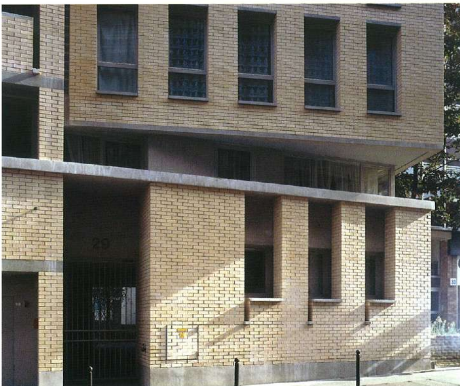
De haut en bas : Vue depuis la rue de Vaugirard Détail de l'entrée Page suivante : Vue de la cour intérieure
