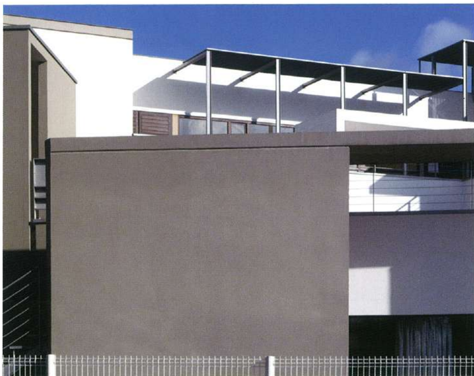
En haut : Vue d'ensemble Ci-contre : Détails de façade
