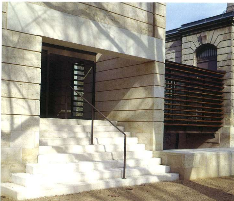
Ci-dessus à gauche : Rampe d'accès handicapés Ci-dessus de haut en bas : Vue intérieure de l'extension de la salle à manger Éclairage de nuit de la salle à manger Terrasse sur le parc et salle à manger Ci-contre : Entrée de l'aile neuve
